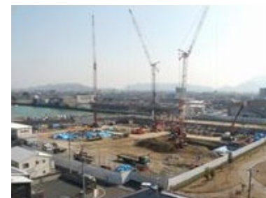
【港町キャンパス建設工事】
